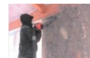
■公認技術士のみが、自然素材が原料の糊と混ぜ、目視によって強度に際なく吹き付けていきます。
